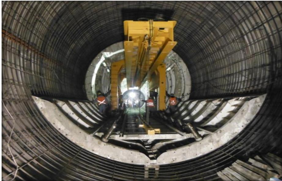
**COLOCACIÓN DE LA CIMBRA TELESCÓPICA PARA REVESTIMIENTO DEFINITIVO EN EL PS, L 24A**
