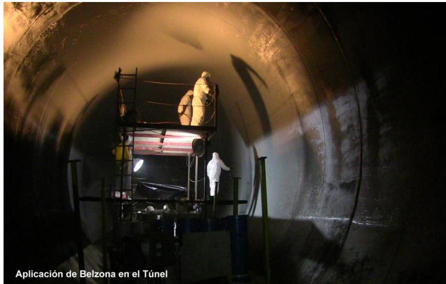
**APLICACIÓN DE BELZONA EN EL TÚNEL, TRAMO II, L 6 Y L 5.**
