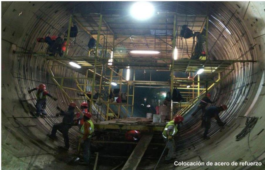
**COLOCACIÓN DE ACERO DE REFUERZO EN EL TRAMO III, L 11 Y L 12**
