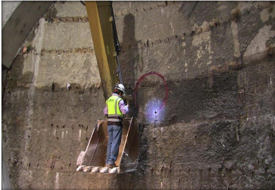
**BARRENO EN EL PORTAL PARA UBICAR LA RUEDA DE CORTE EN EL TRAMO II, L 10.**
