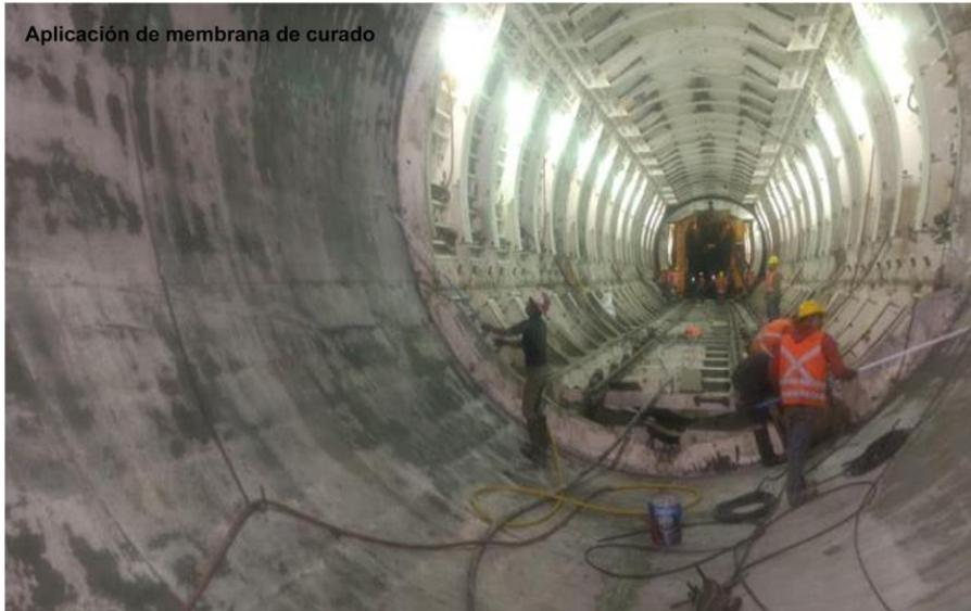
**APLICACIÓN DE MEMBRANA DE CURADO EN EL PORTAL DE SALIDA, L 24A.**
