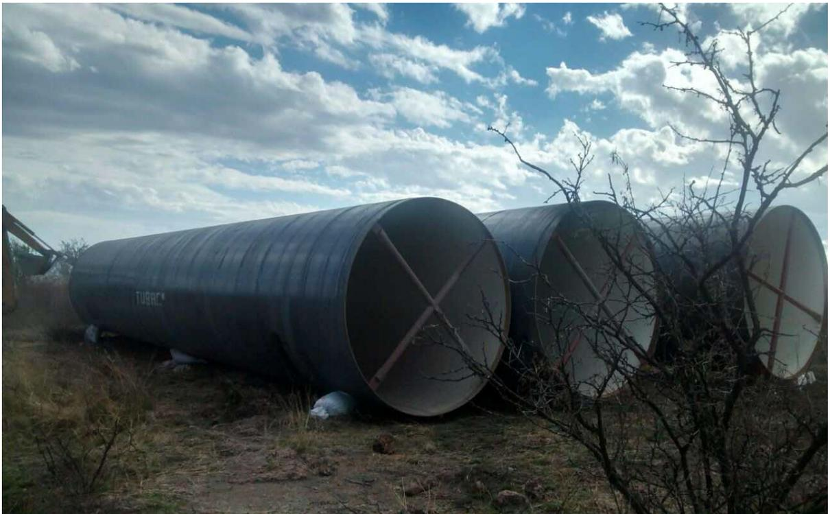
Figura 26.- Acopio en sitio de tubería de acero.
