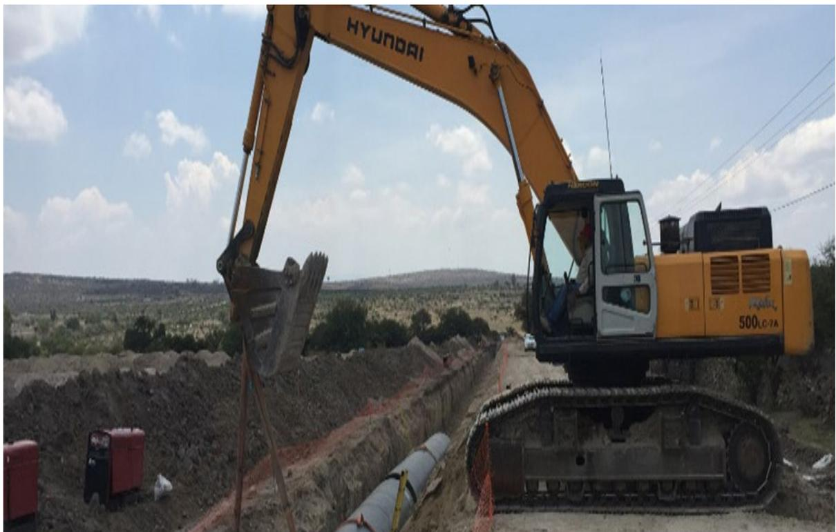
Figura 16.-Línea de Conducción.
