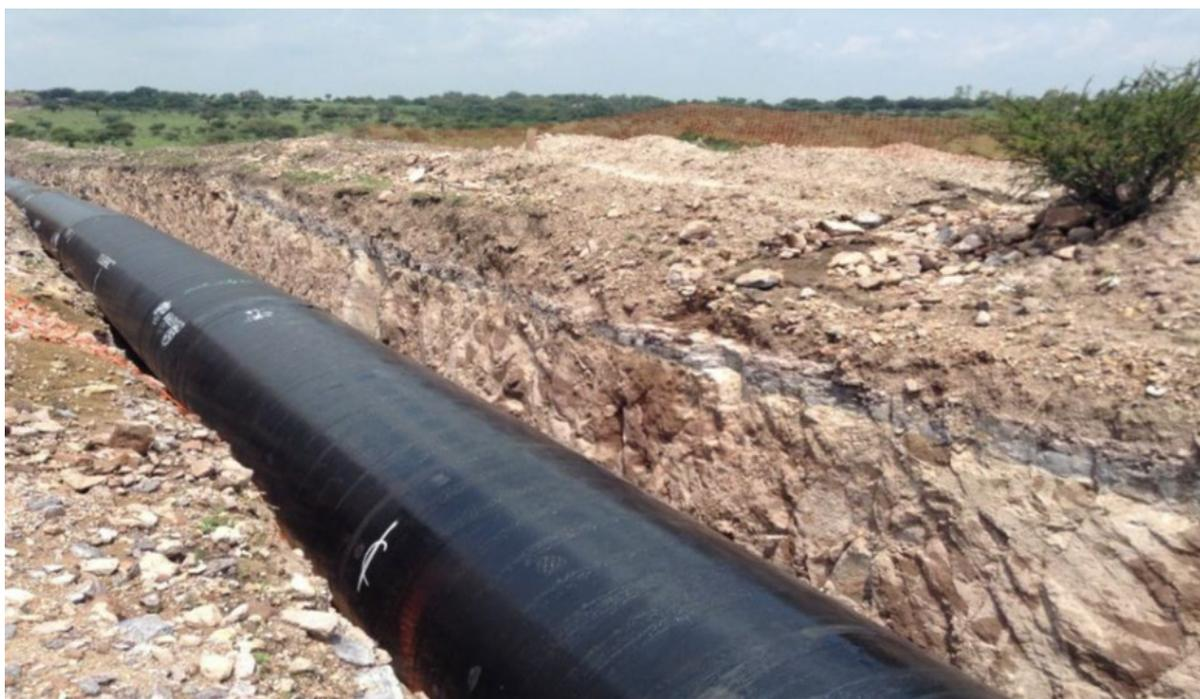
Figura 21.- Línea de Conducción en zanja.
