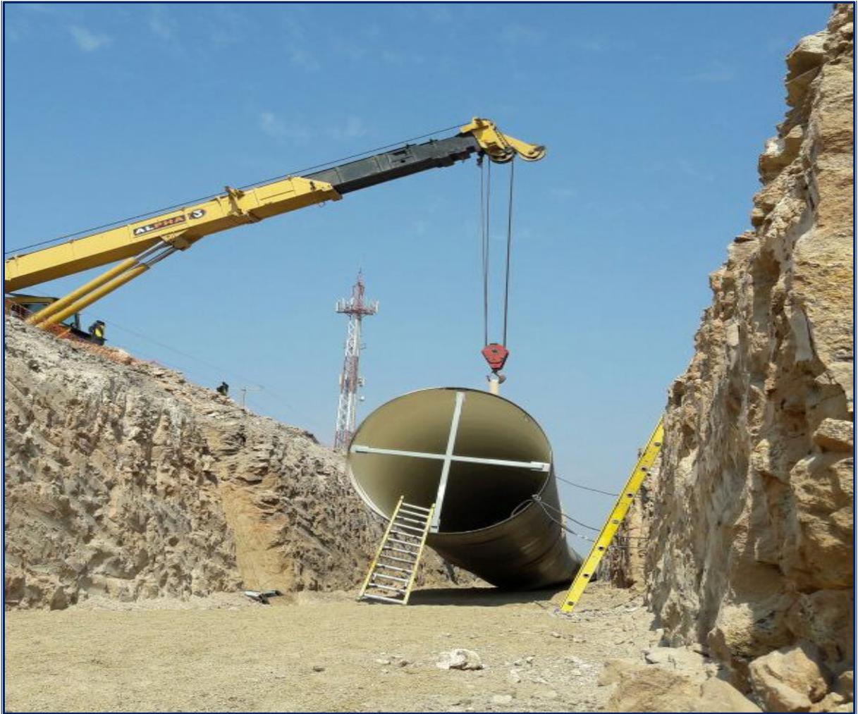
Figura 3.- Construcción de la Línea de Conducción.
