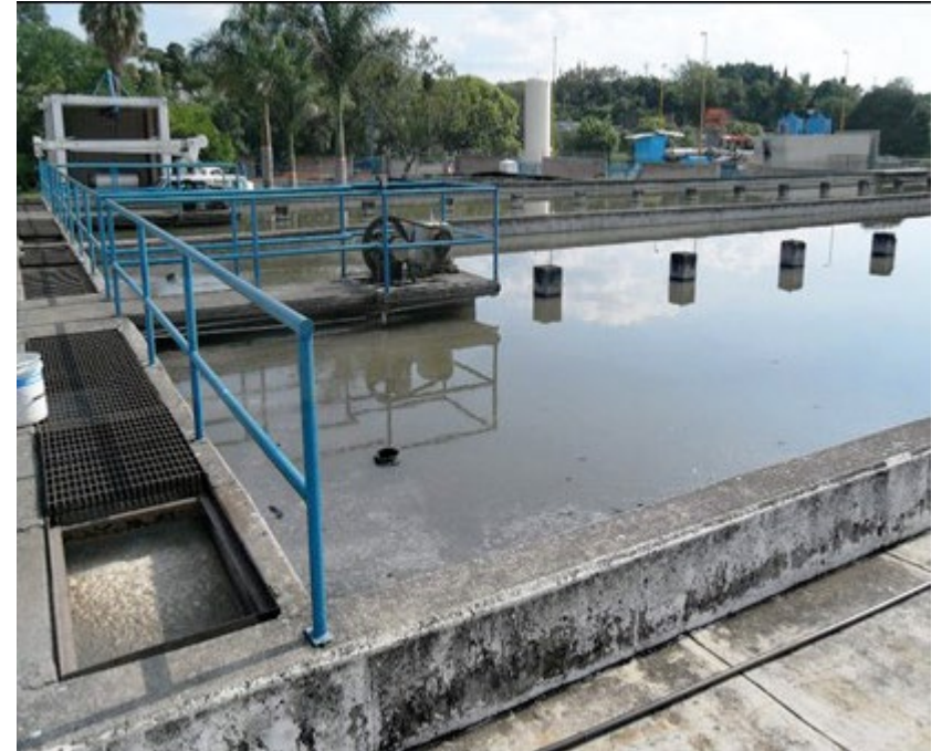
Sedimentador secundario
