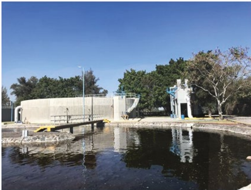
Sedimentador secundario
