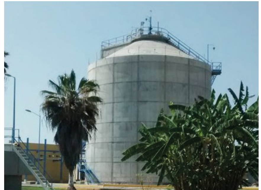
Digestor anaerobio de lodos
