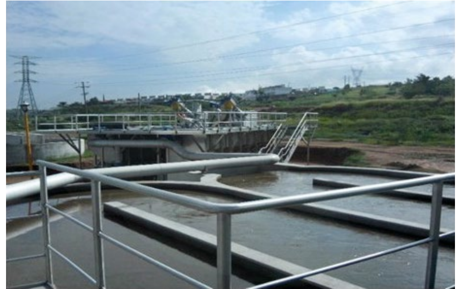
Zanja de oxidación
