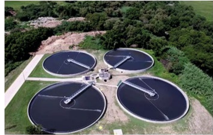
Sedimentador secundario
