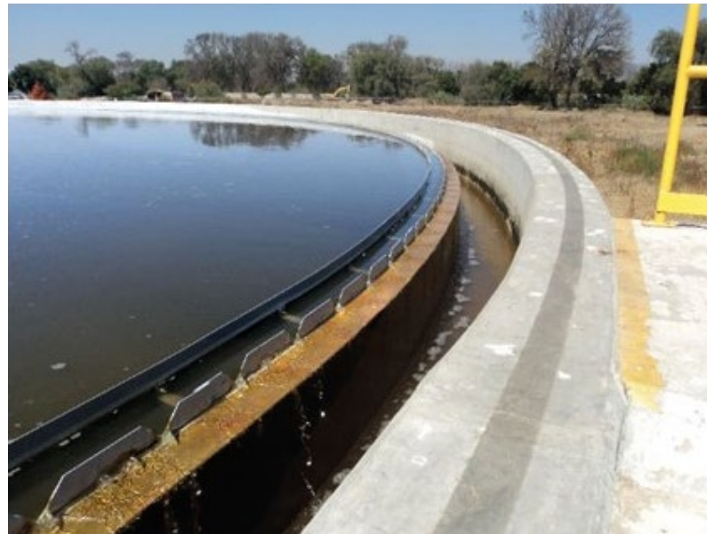
Sedimentador secundario
