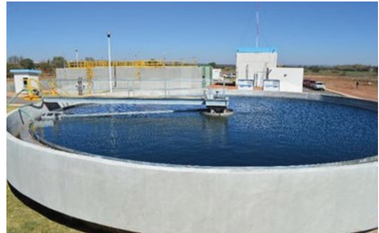
Sedimentador secundario
