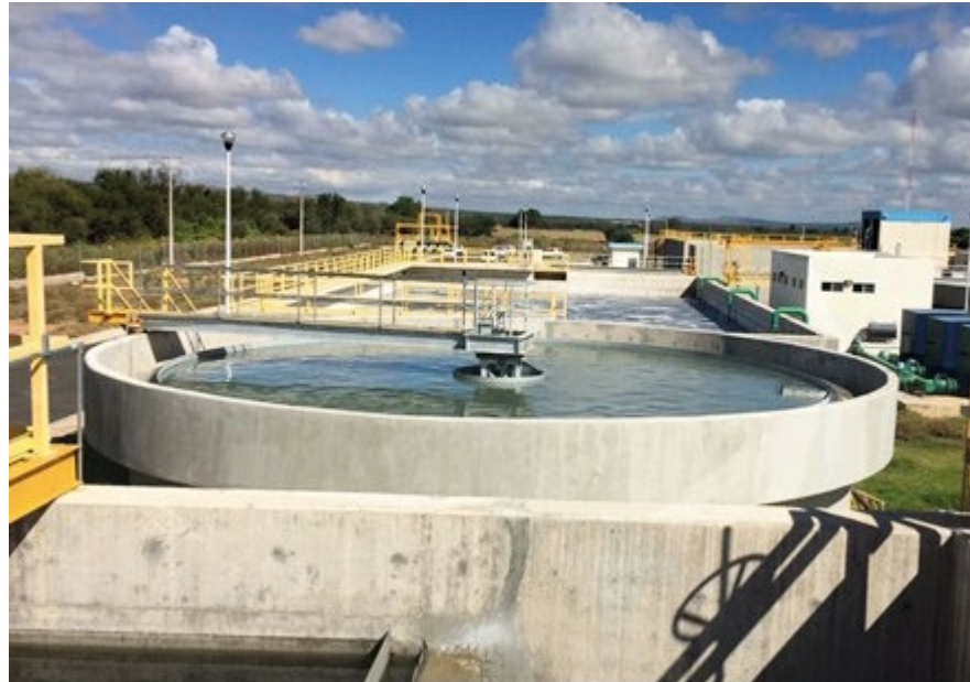
Sedimentador secundario
