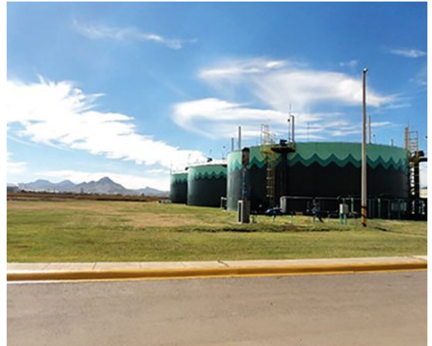
Digestores Anaerobios
