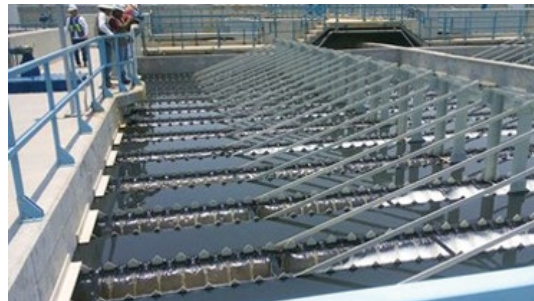
Sedimentador secundario
