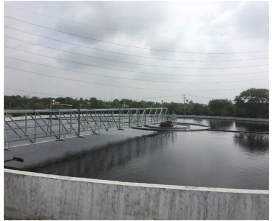
Sedimentador secundario
