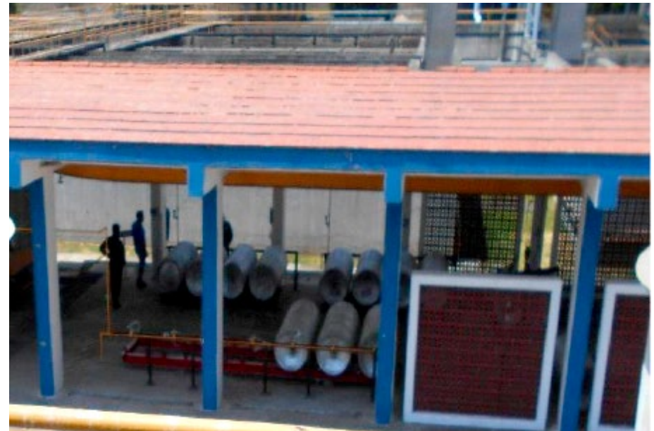
Edificio de cloración
