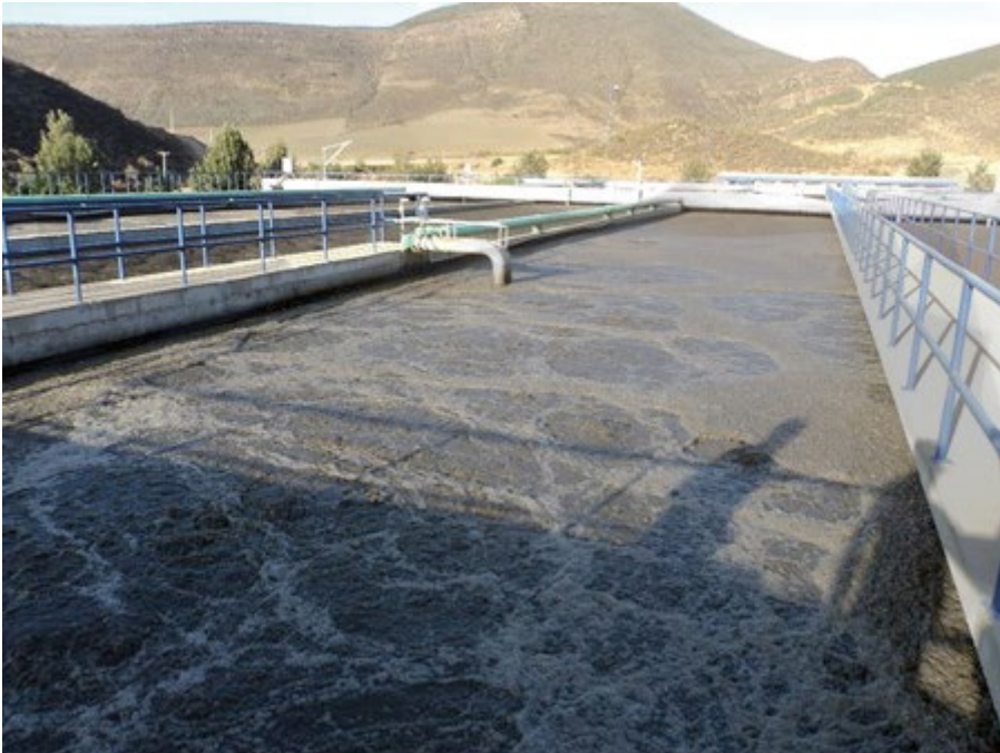
Zanjas de oxidación
