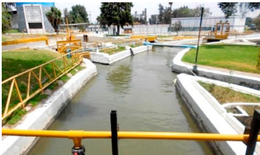
Canal de entrada
