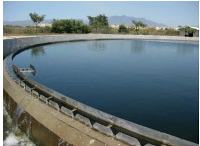
Sedimentador secundario
