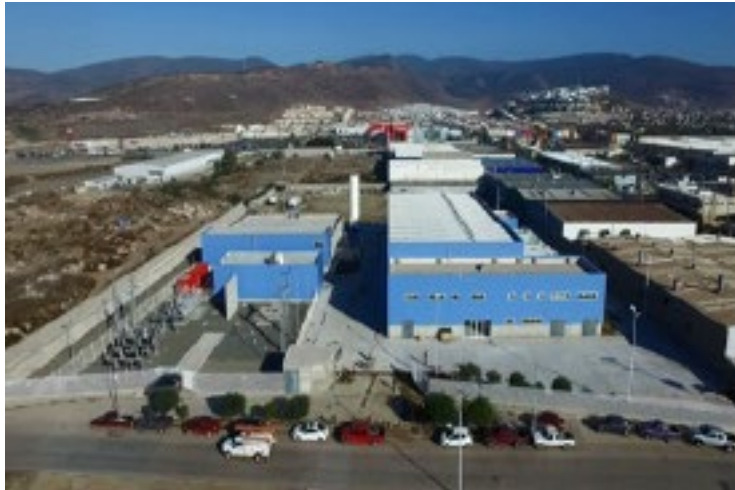
Vista general de la planta
