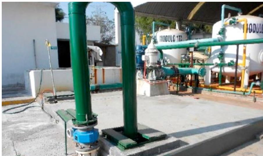
Cárcamo de llegada
