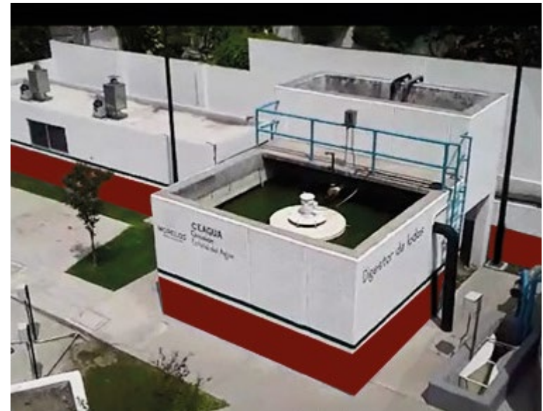
Digestor aerobio de lodos
