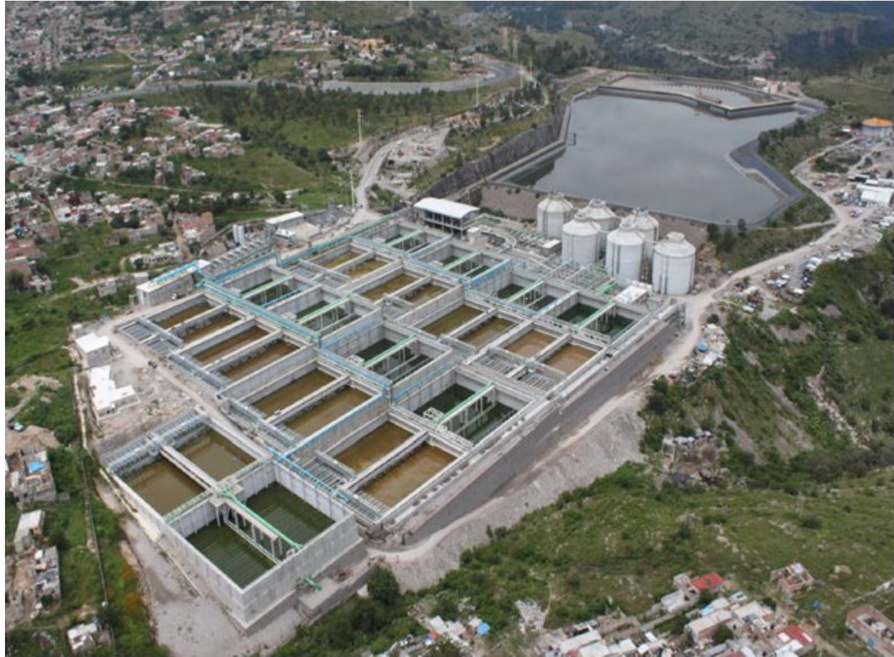
Vista aérea de la planta
