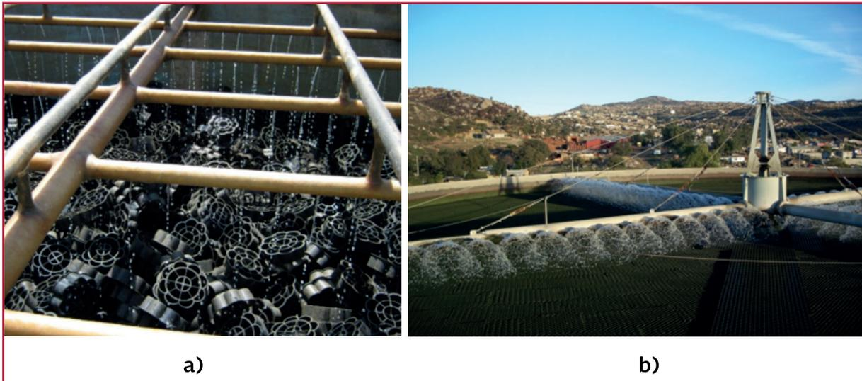
Tradicionalmente, el medio usual ha sido el de piedra quebrada. Cuando se cuenta localmente con buen material, la principal ventaja es su bajo costo. Cualquier roca usada como medio filtrante debe ser de tamaño uniforme para asegurar volumen de vacíos adecuado para el paso del agua y circulación del aire. El tamaño efectivo de la roca es de 75 a 125 mm (3 a 5 pulgadas). Las piedras de menor diámetro no proporcionan suficiente volumen de
