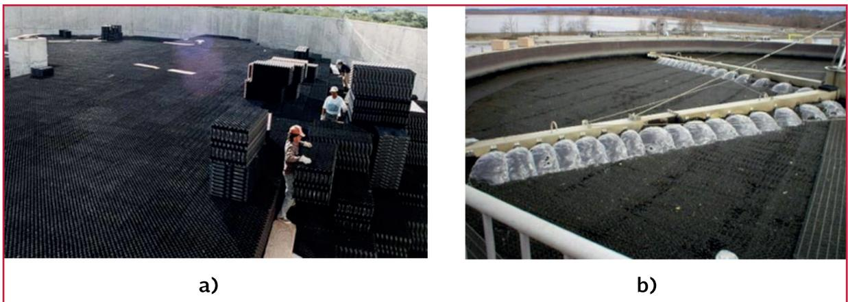
nima del filtro es de 1.5 metros. La profundidad máxima del filtro de roca es de 3 m por el peso de la roca. Los medios de madera y plástico pueden tener profundidades de 10 m o más. La profundidad máxima de estos medios depende del análisis de costo de bombeo. El tiempo de paso a través del filtro se incrementa con la profundidad y por tanto el grado de tratamiento.
