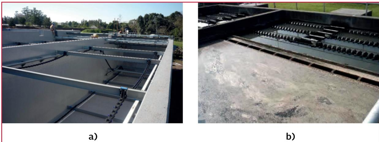
La alimentación se hace en un extremo y la recolección de agua sedimentada en el extremo opuesto. El lodo que se deposita en el fondo del sedimentador es acarreado por medio de la raspa a un extremo donde se han construido tolvas y se extrae por medios mecánicos o hidráulicos.
