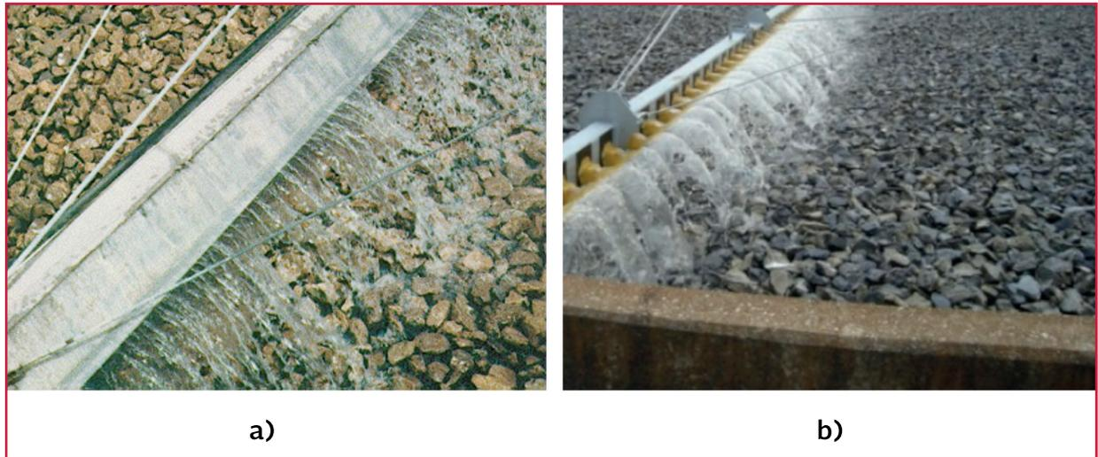
Ilustración 2.6 a) altura de un filtro rociador con medio de piedra y de plástico b) medio filtrante: madera
