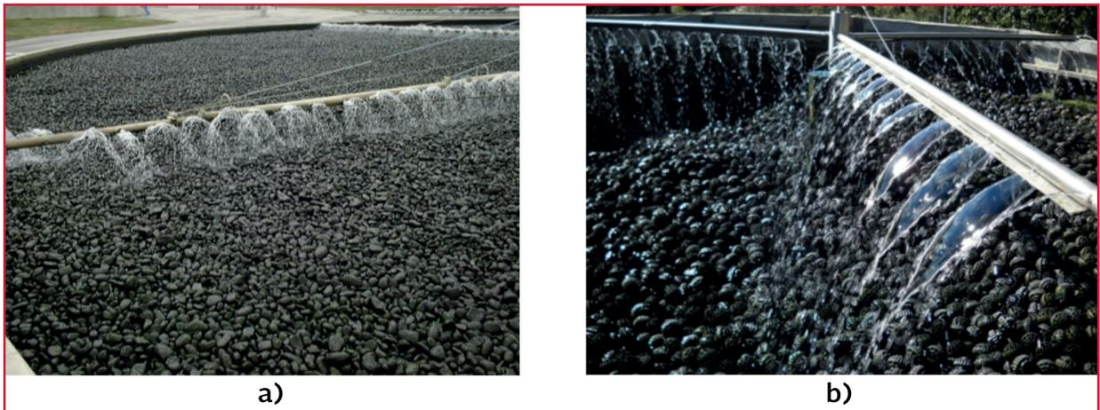
que alimenta el filtro de aguas residuales y observar cuidadosamente el giro de los brazos del distribuidor, así como la correcta difusión del desecho sobre el medio filtrante.
