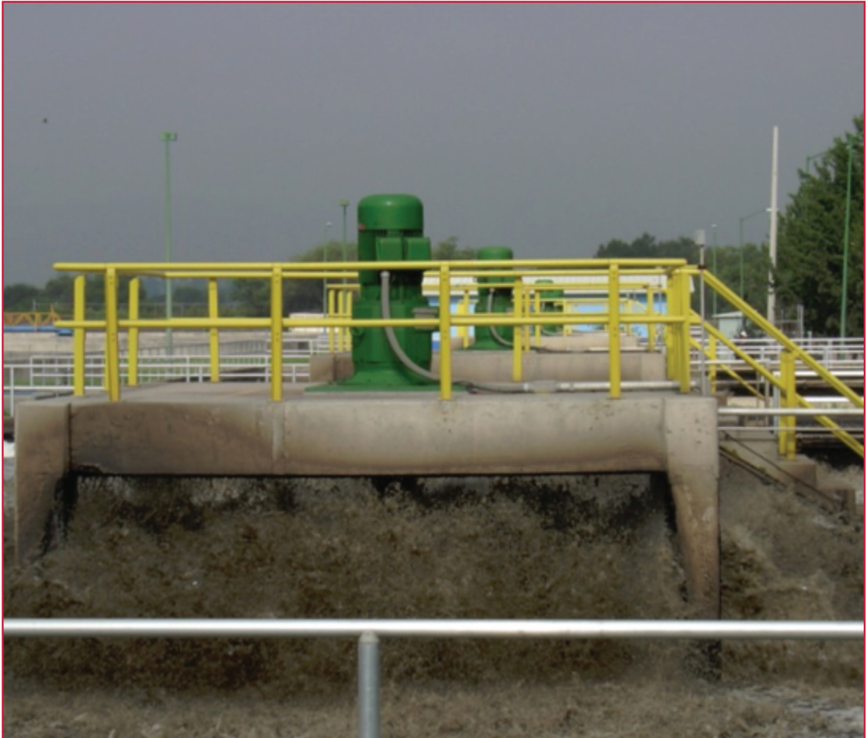
Ilustración 1.11 Aireador superficial (Fuente: CONAGUA, 2014)
