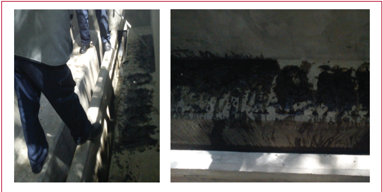
Ilustración 2.6 Limpieza de entrada y salida de agua del sedimentador
