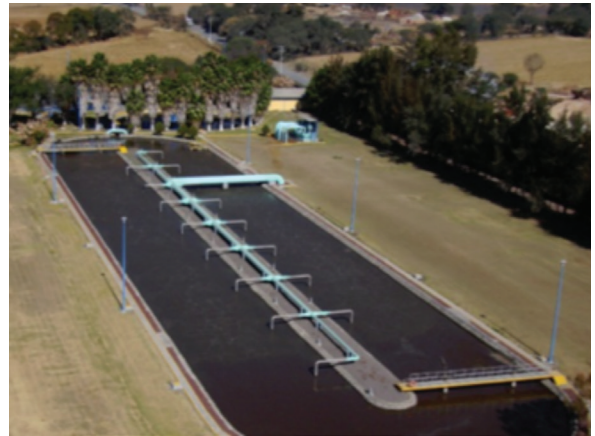
Ilustración A.16 Zanja de oxidación aireación por difusión
