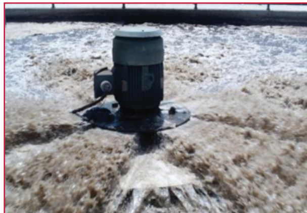
Ilustración A.4 Difusión de aire con aireador mecánico flotante
