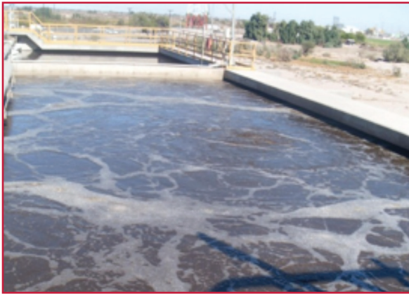
Ilustración 1.27 Difusor dañado
