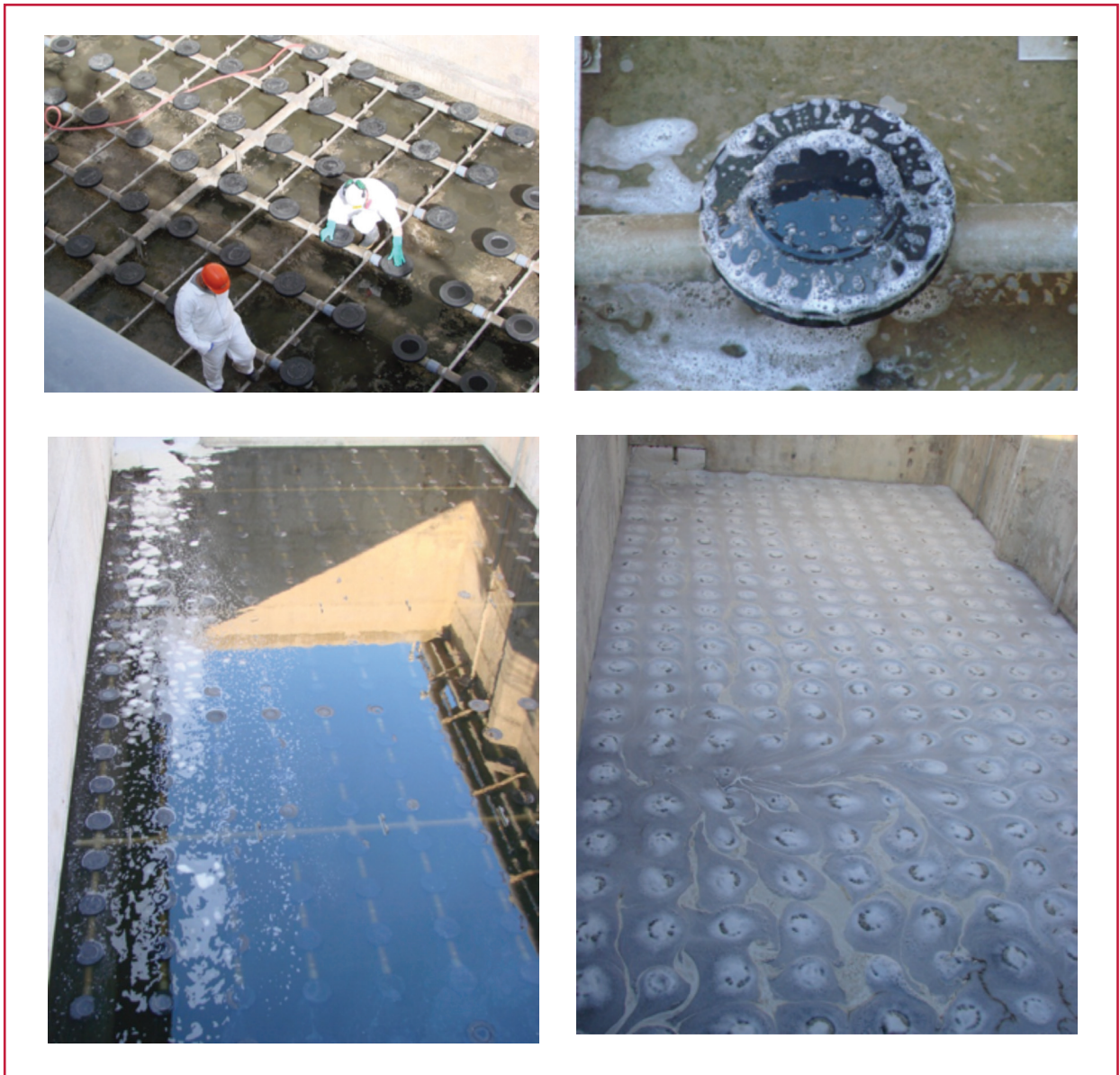
Ilustración 2.8 Revisión de difusores
