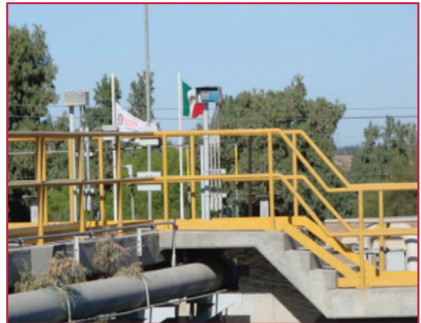
Ilustración 5.2 Barandales en sedimentador secundario
