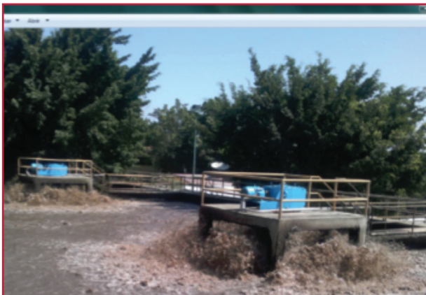
Ilustración A.3 Difusión de aire con aireador mecánico fijo
