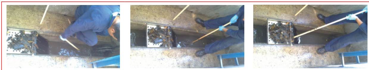
Ilustración 1.58 Limpieza manual de rejillas
