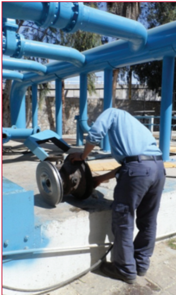
Ilustración 2.17 Revisión del impulsor
