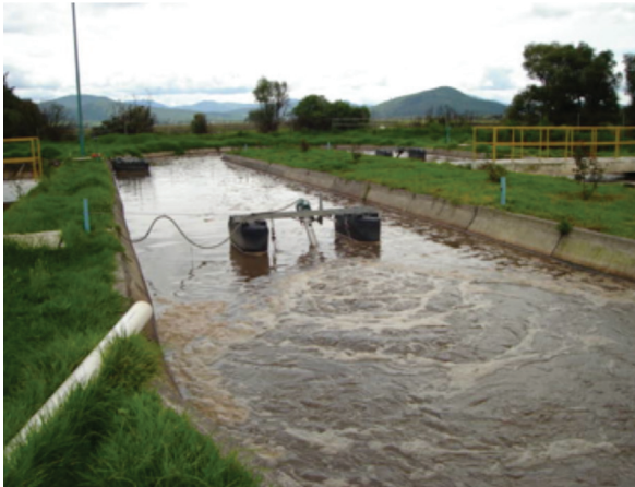
Ilustración A.15 Zanja de oxidación aireación superficial
