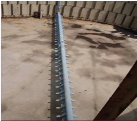
Ilustración 3.17 Sistema de aireación en tanque de aireación
