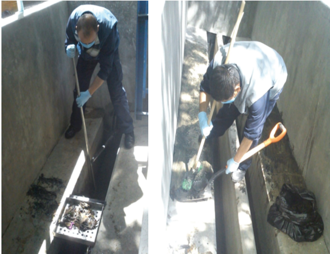
Ilustración 2.4 Limpieza de canales y rejillas
