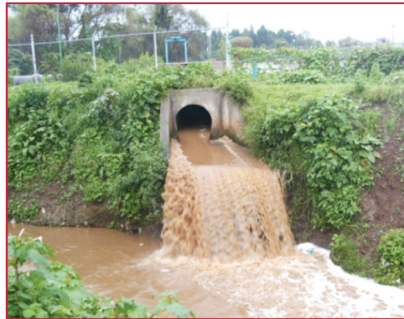
Ilustración 1.41 Desvío de agua de lluvia
