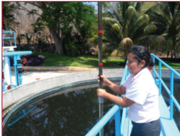
Ilustración 1.61 Determinación del manto de lodos
