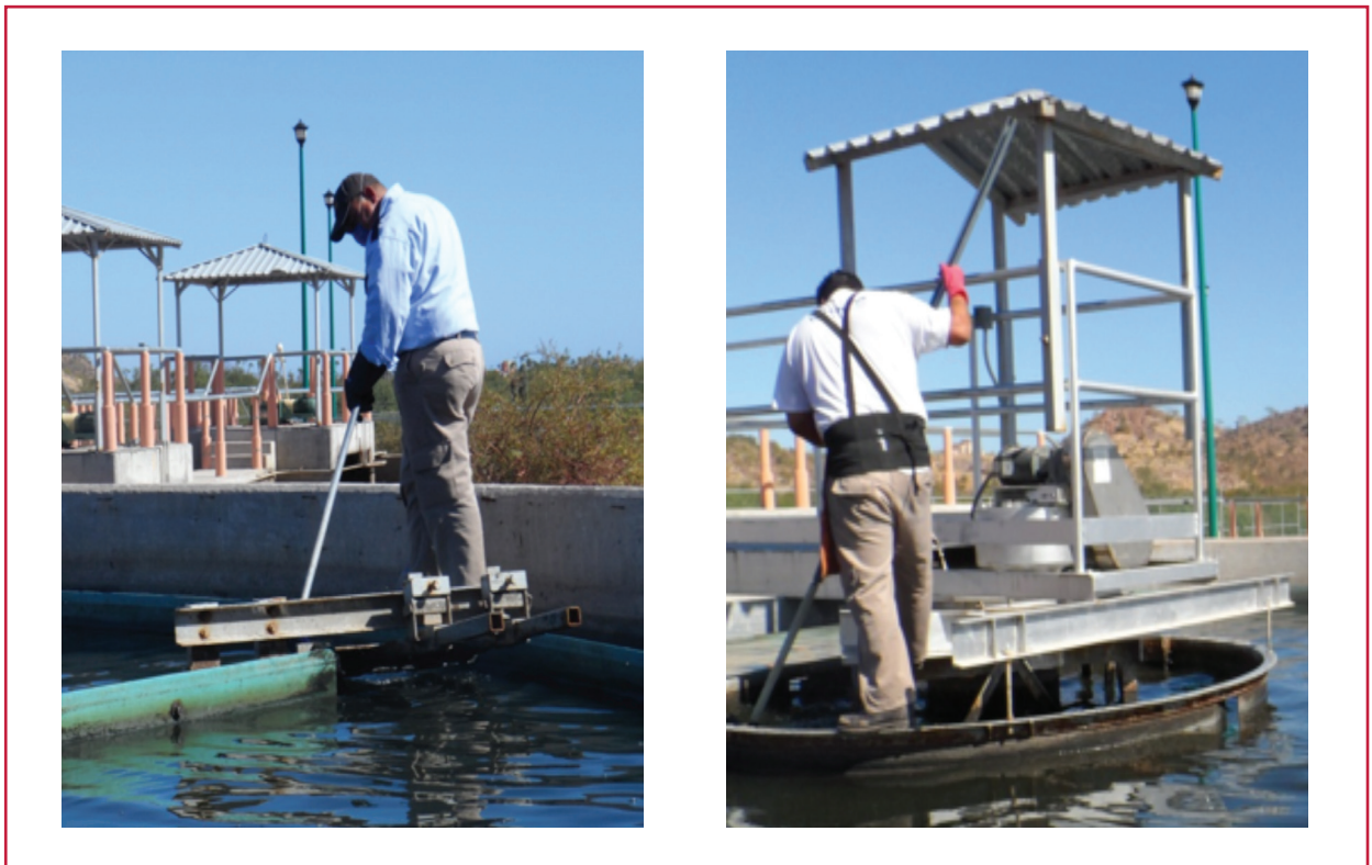
Ilustración 2.6 Limpieza de entrada y salida de agua del sedimentador
