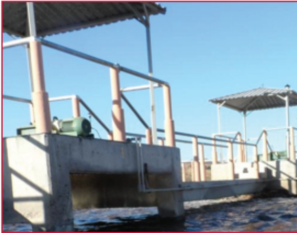
Ilustración 5.1 Barandales en tanque de aireación
