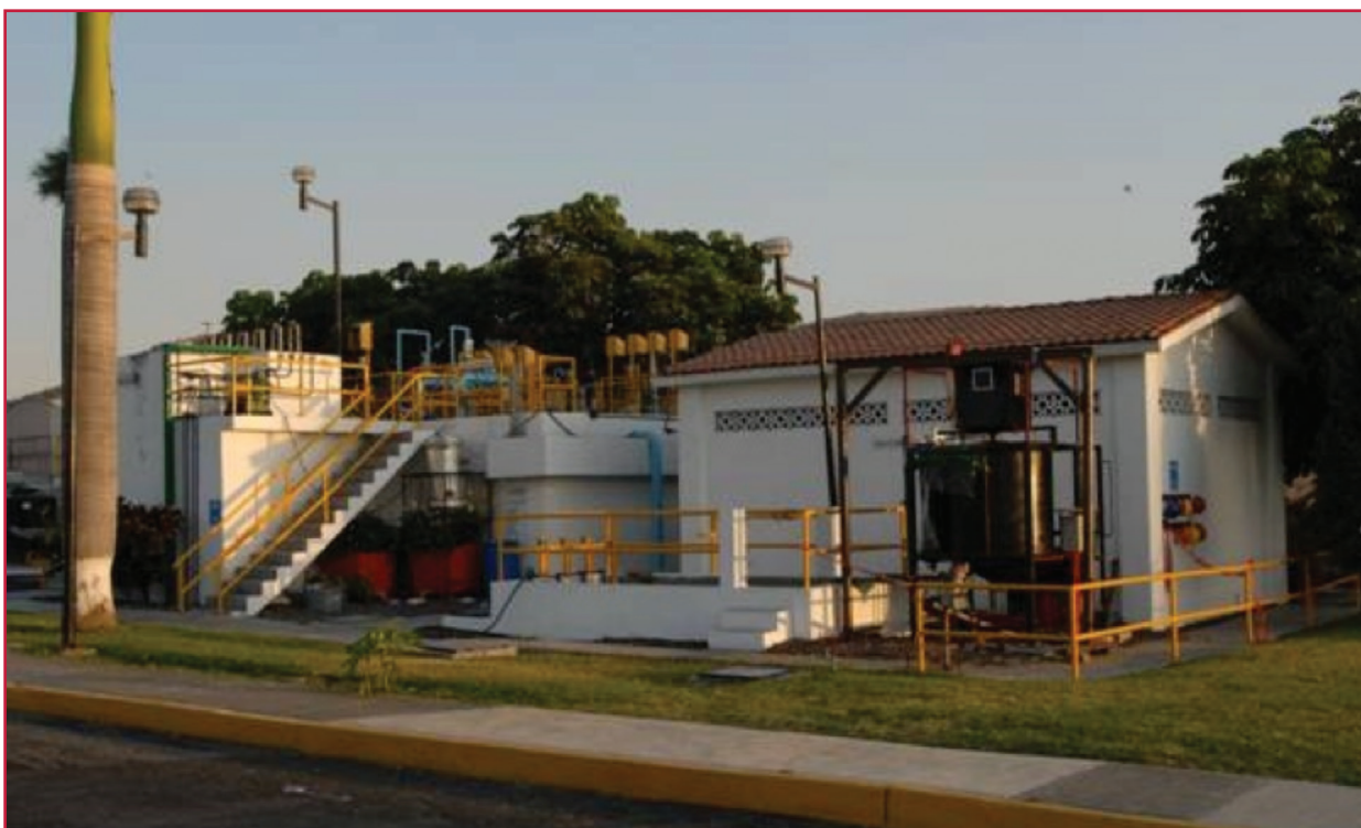
Ilustración 2.1 PTAR limpia y en buenas condiciones
