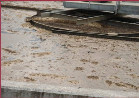
Ilustración 1.38 Presencia de grasas y aceites en clarificadores secundarios mayores a 100 mg/L
