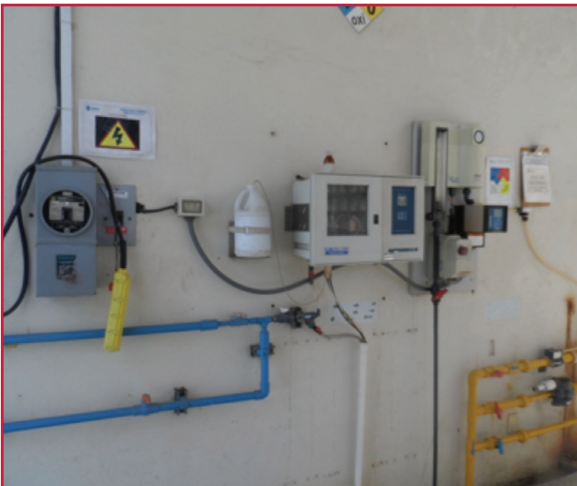
Ilustración 2.10 Sistema de cloración
