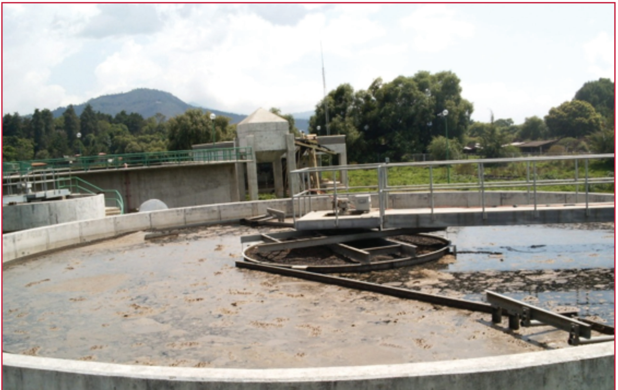
Ilustración 1.17 Arrastre de flóculos hacia la superficie
