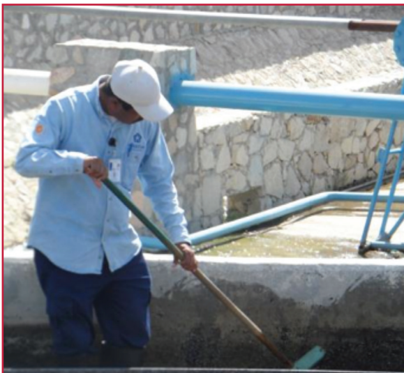
Ilustración 1.65 Limpieza de canaletas
