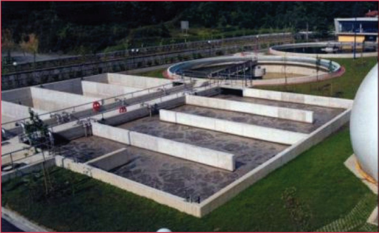
Ilustración A.9 Sistema de aireación decreciente
