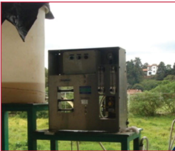
Ilustración 2.14 Sistema de dosificación del polímero
