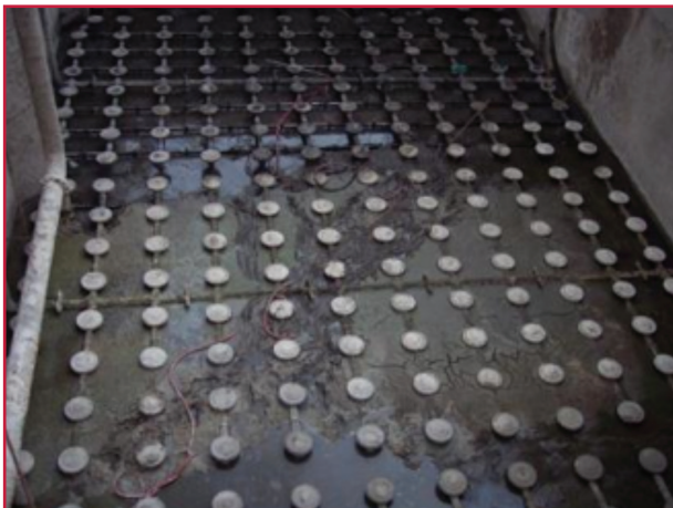
Ilustración A.3 Difusión de aire con aireador mecánico fijo
