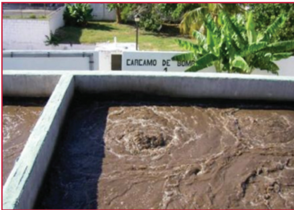
Ilustración 1.27 Difusor dañado
