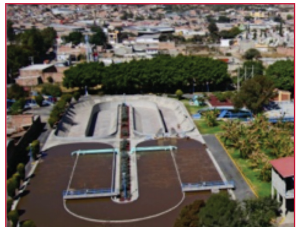
Ilustración C.17 Zanja de oxidación
