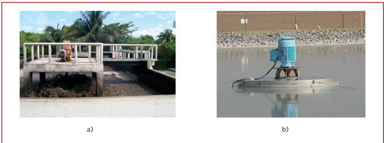
tubo de inyección y una hélice montados sobre una balsa. Presentan la ventaja de poder inclinar el tubo de inyección de aire y provocar una corriente de circulación de agua. Este tipo de aireadores produce un chorro de aire presurizado que previene cortos circuitos hidráulicos, y reduce la pérdida de calor en el agua, lo que contrarresta las condiciones ambientales extremadamente frías del invierno (Ilustración 2.8 e Ilustración 2.4).
