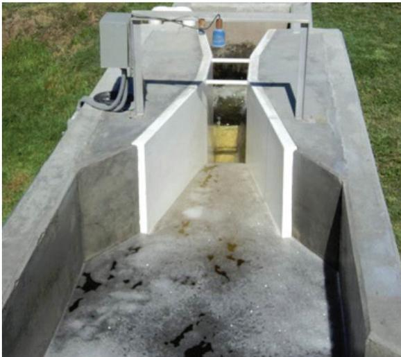
Ilustración 1.6 Afluente a una laguna
