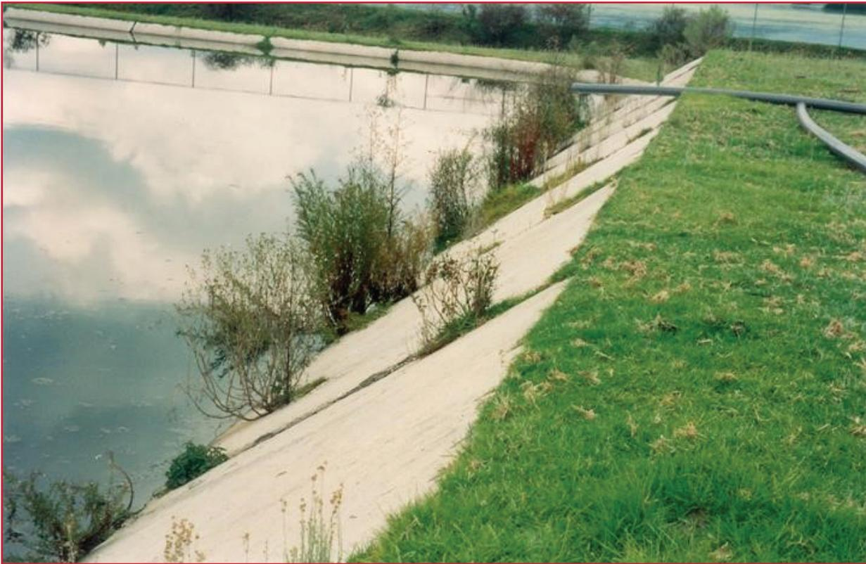
Ilustración 4.17 Estructura superficial en una laguna y presencia de vegetación en los bordos
