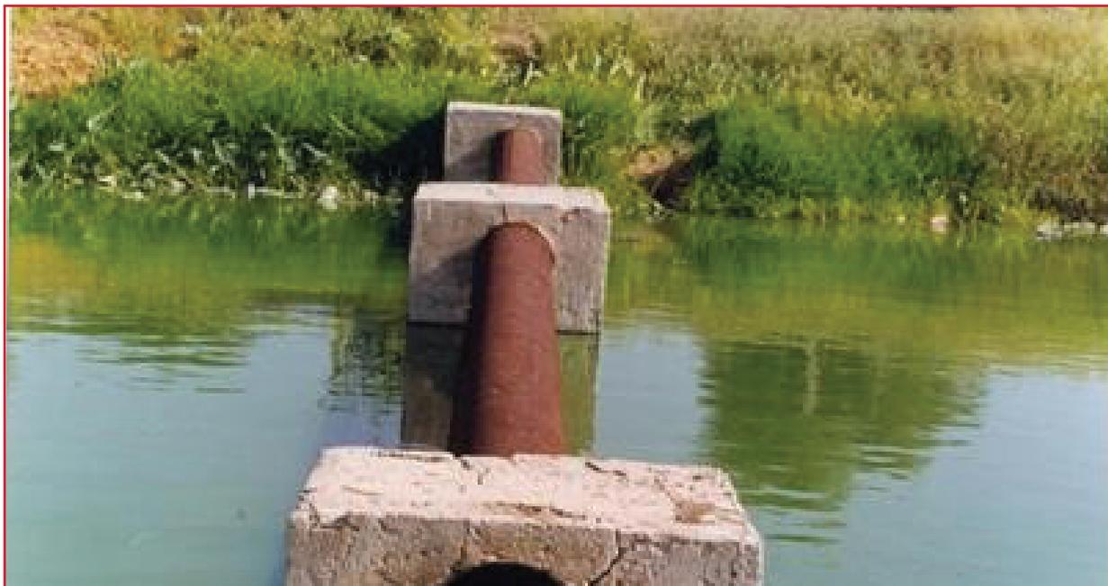
Ilustración 4.18 Estructura de salida de una laguna de estabilización que requiere operación y mantenimiento
