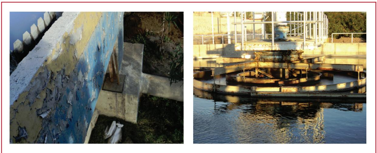
Ilustración 2.16 Falta de atención en sedimentadores primarios
