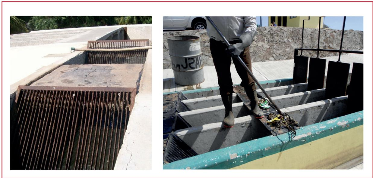
Ilustración 1.5 Rejas y rejillas de limpieza automáticas
