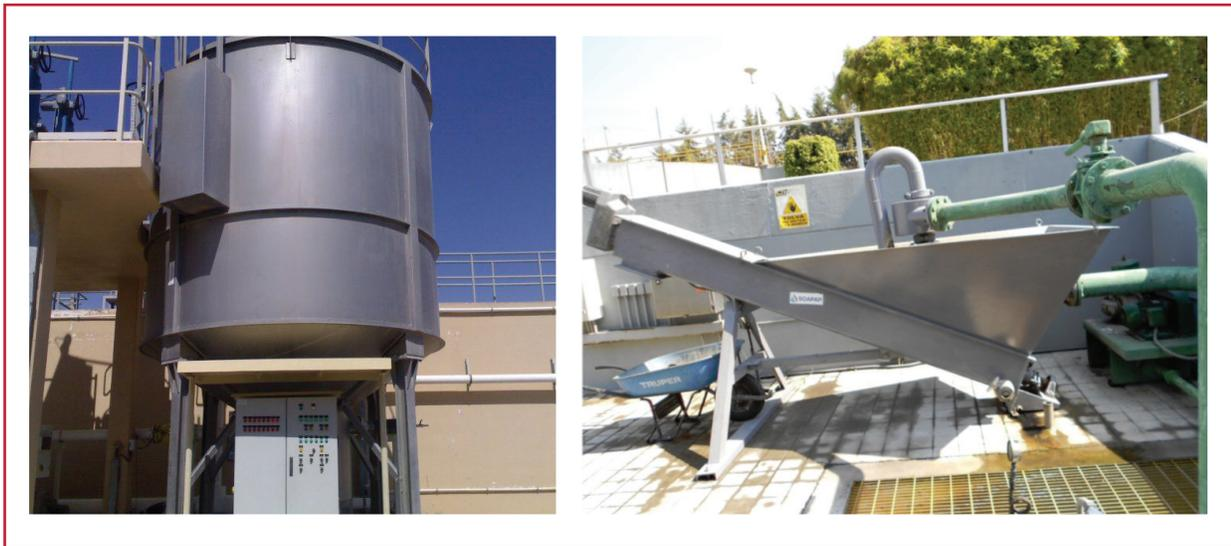
forme una adecuada rotación del manto líquido y supervisar el funcionamiento de los equipos mecánicos como paletas rotatorias y bombas de lodo, así como retirar la arena al menos una vez al día. Su mantenimiento consiste en conservar en buenas condiciones los equipos de extracción y lavado de arenas.
