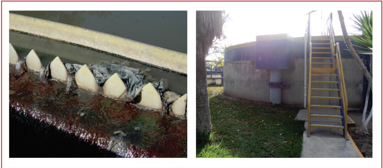
Ilustración 2.15 Sedimentador con falta de mantenimiento y partes metálicas con alta corrosión, respectivamente
