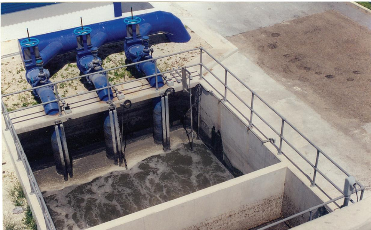
Ilustración 1.3 Obra de llegada y desvío (demasiás o bypass) antes del desarenador en una planta de tratamiento de aguas residuales
