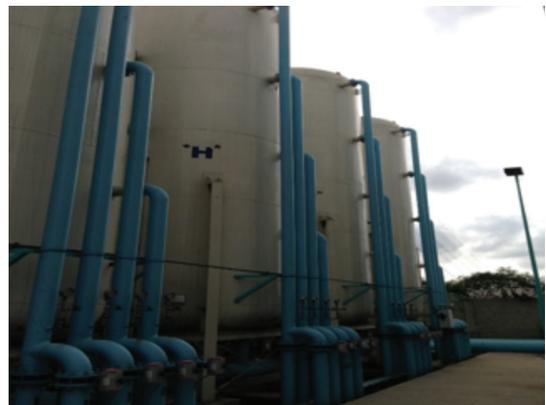
Filtración directa (La Caldera, Del. Iztapalapa, México D.F. Caudal de diseño: 600 L/s)
