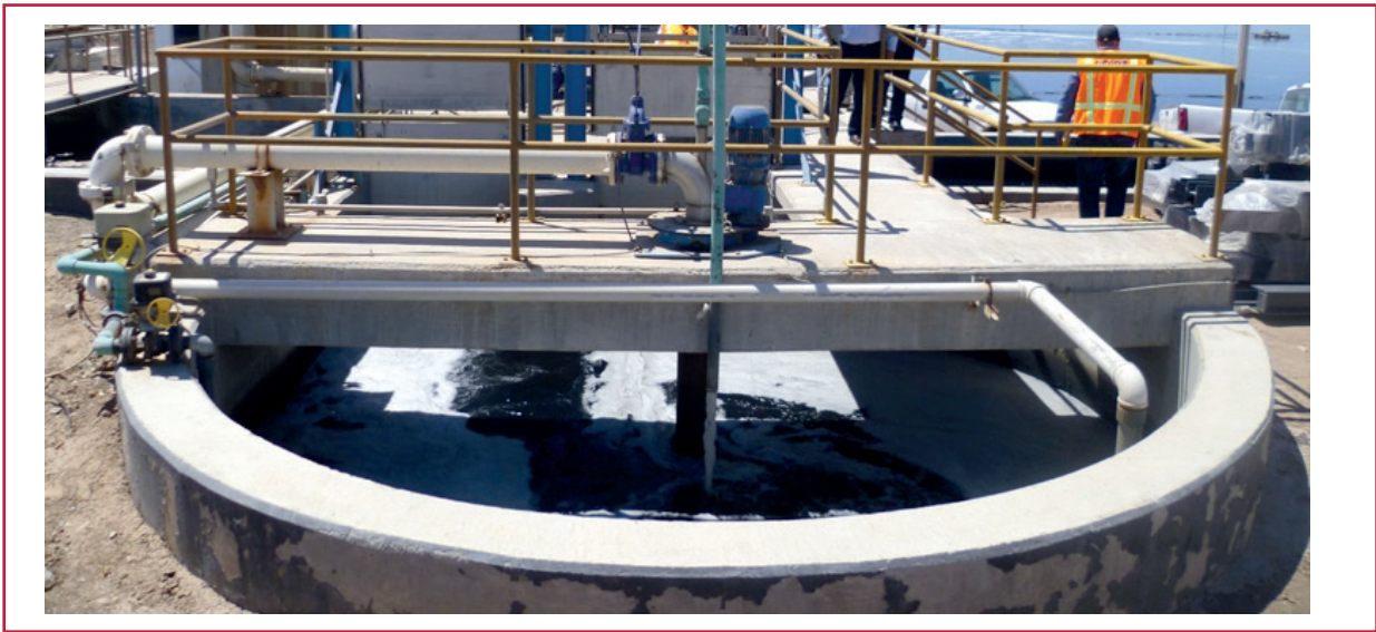
Ilustración 1.12 Desarenadores de vórtice a) Sistema PISTA b) Sistema Teacup
