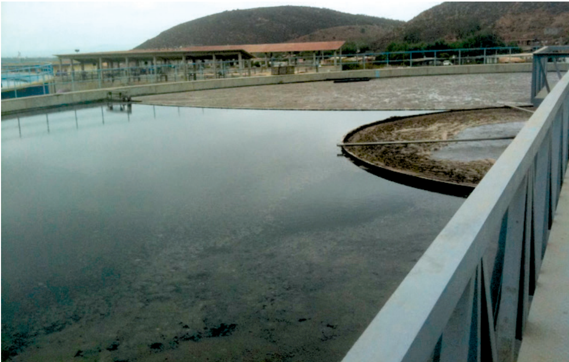
Ilustración 2.1 Ubicación del clarificador primario en una planta de tratamiento
