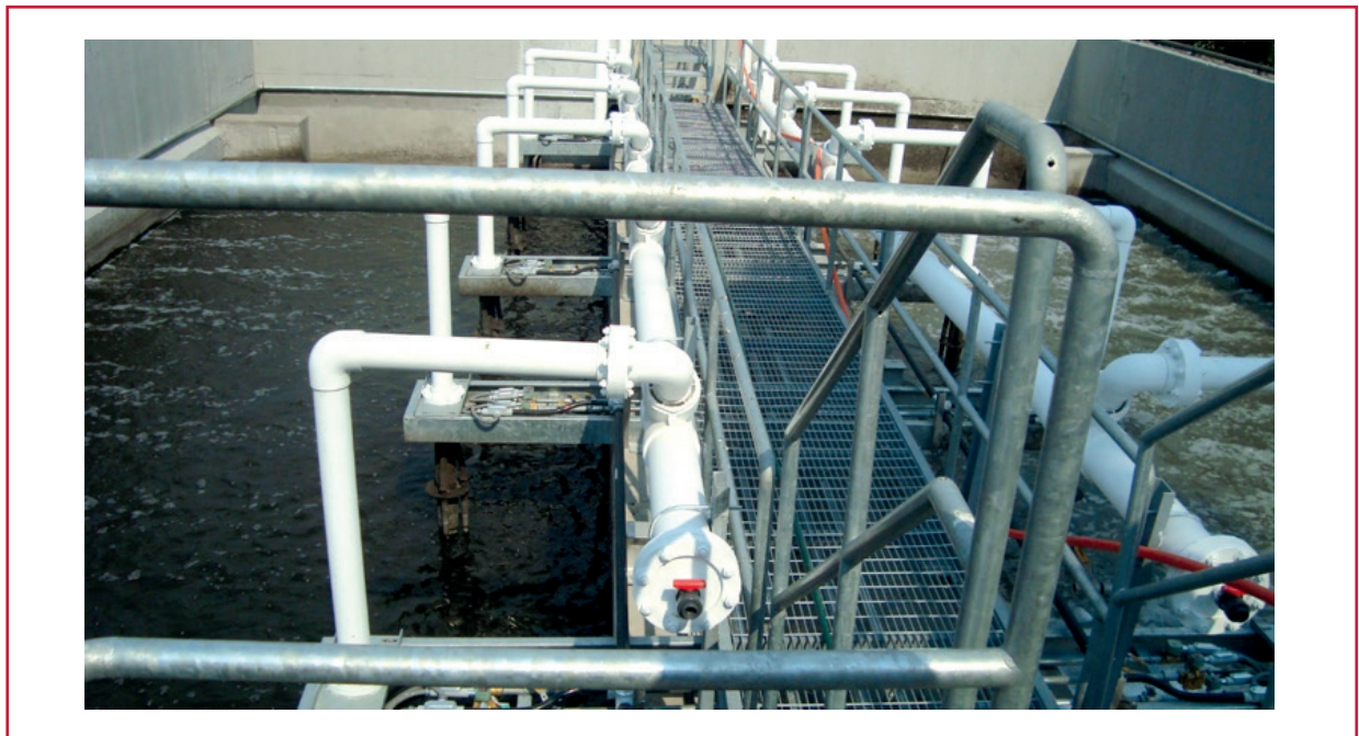
Ilustración 1.8 Desarenador aireado
